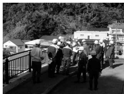
七軒町地区急傾斜地崩壊防止工事
