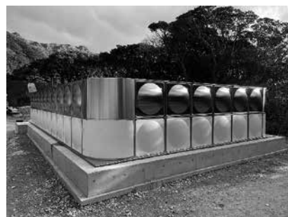
大沢配水池新設工事
