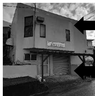
令和5年度整備 2階部分：シャワー室
