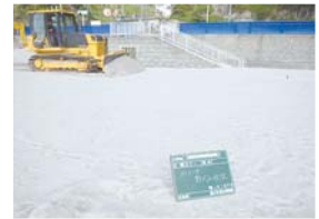
平成26年度神津島港海岸養浜工事 敷均し状況
