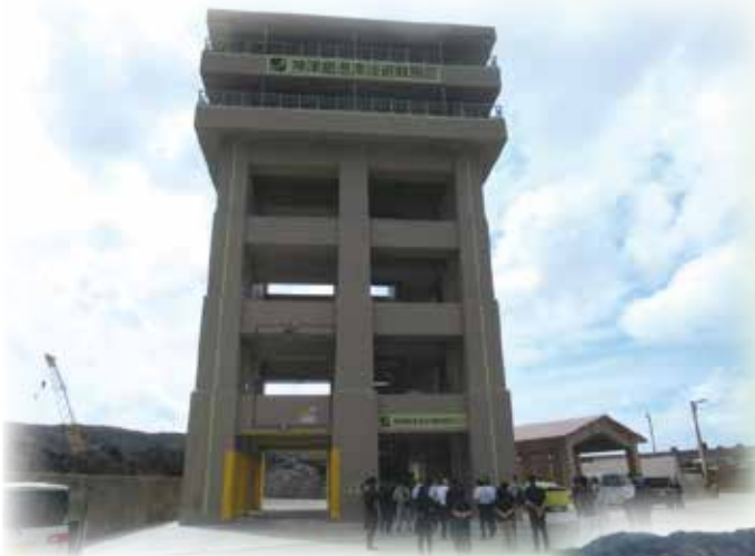
神津島港津波避難施設の視察
