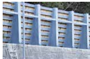
多幸治山施設機能保全工事 (多目的広場)
