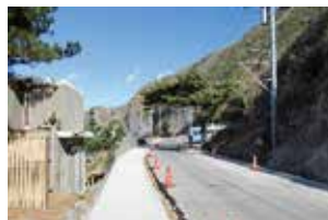
村道14号線道路改修工事 (エンマ堂先)
