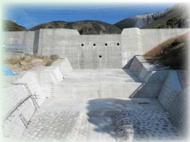
議会現場視察 神津沢砂防工事鉄砲場(3号堰堤)
