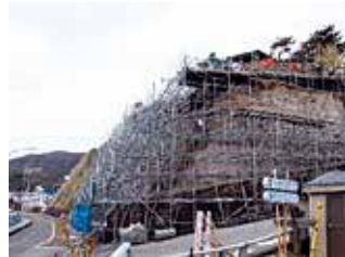
道路災害防除工事（役場下法面）
