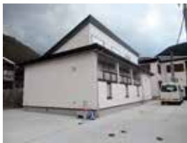
女子寮建設工事
