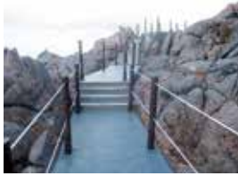
赤崎遊歩道整備工事
