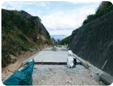
村道 86 号線道路舗装改修工事
