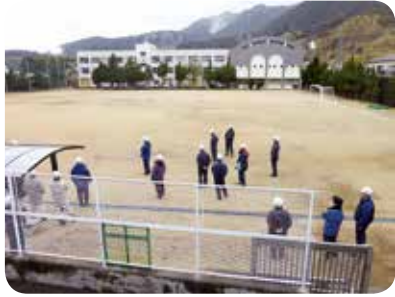
◎中学校校庭夜間照明設置工事◎
