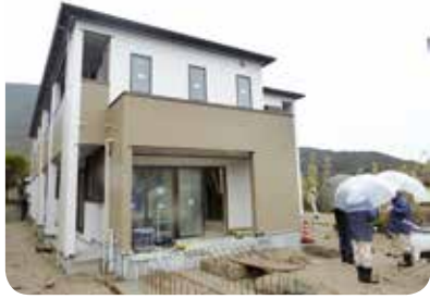
◎神津島村学生寮建設工事◎
