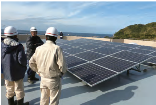
◎太陽光発電設備等設置工事◎ (生きがい健康センター)
