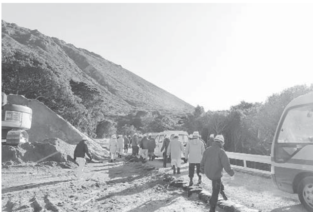
<沖の沢(新都道)工事現場>
