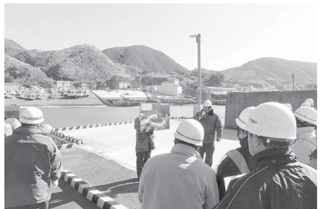
<神津島港船揚場(改良)建設現場>
