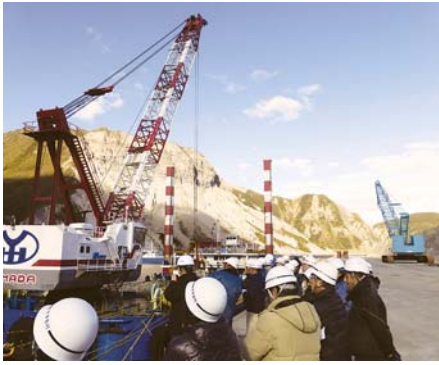
三浦漁港 3.0 m 岸壁建設のようす
