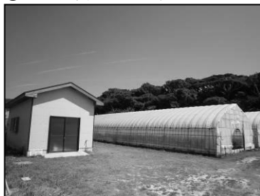
⑧田の沢農業研修施設
