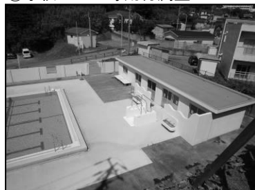
⑱学校プール専用付属室
