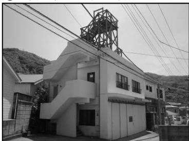
⑰消防団拠点施設（新詰所）
