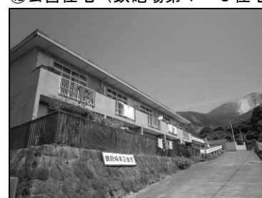
⑫公営住宅（鉄砲場第1～5住宅）
