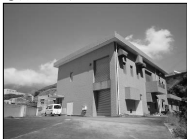
⑲農業集落排水処理施設
