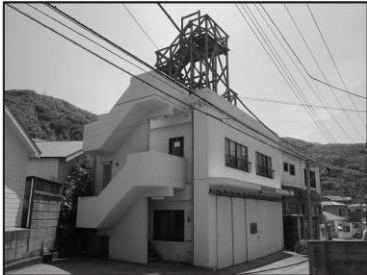
⑯消防団拠点施設（新詰所）
