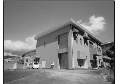
⑱農業集落排水処理施設
