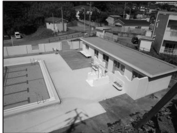
⑰学校プール専用付属室
